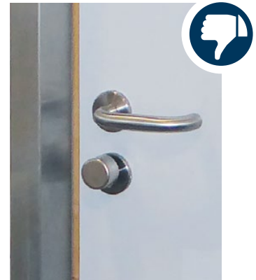
Drehgriffe wie z.B. Knäufe sind ungeeignet und nicht barrierefrei.
