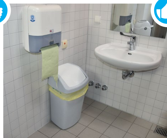
Gut erreichbar ist die Einhandwaschtischarmatur mit langem Dreharm, damit auch Menschen im Rollstuhl selbstbestimmt ihre Hände waschen können. Ebenfalls gut erreichbar ist der Handtuchspender.
