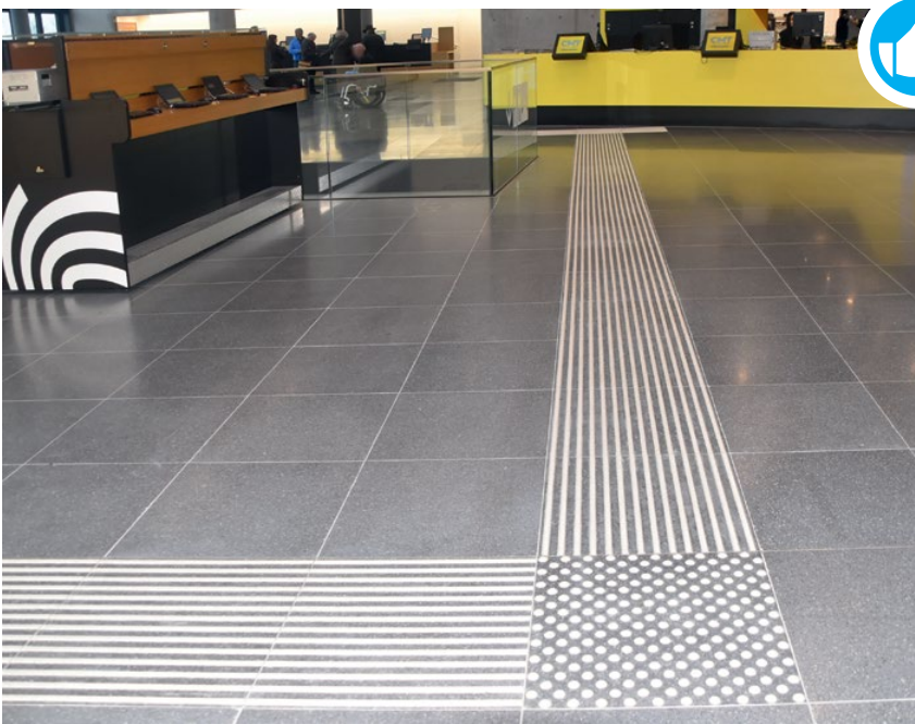
Taktile wahrnehmbare Leitlinien (Bodenindikatoren) führen innerhalb des Gebäudes bis zur Informationstheke.
