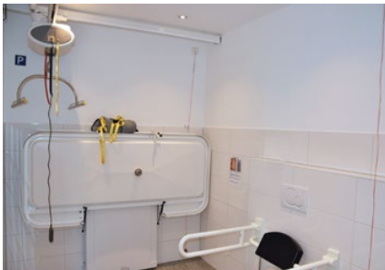
Schauinslandbahn Talstation, Horben
