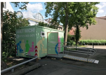
barrierefreier Zugang über Rampe und Innenansicht Reutlingen
