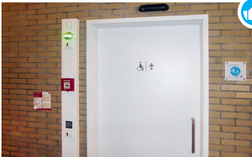
Praxisbeispiel „Toilette für alle“ im Rathaus Reutlingen. Außen signalisiert eine Signalleuchte, ob der Raum frei („grün“) oder besetzt („rot“) ist.
