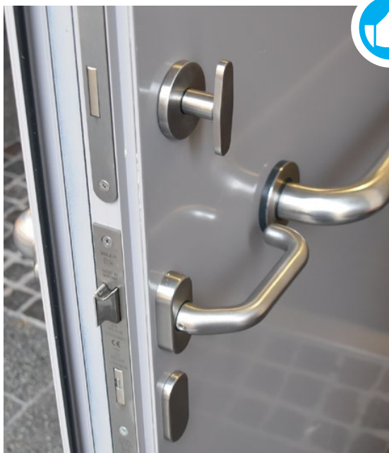
Gut erfassbarer Griff, um die Türe von innen zu verriegeln.
